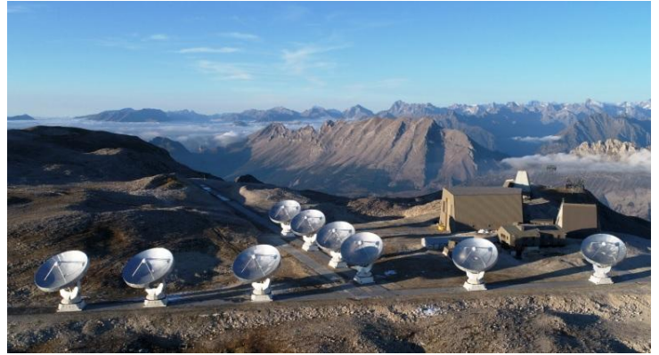
NOEMA , l'observatoire Northern Extended Millimeter Array, le radiotélescope montrant une partie des douze antennes de Ø 15 m. Durant les observations, les antennes fonctionnent comme un télescope unique, utilisant une technique nommée interférométrie.
