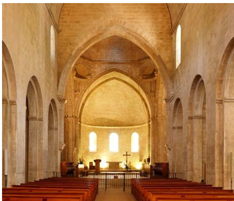
Intérieur de l'église cistercienne en pierre de taille
