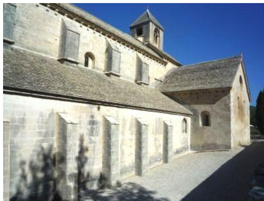
Façade Est de l'église, avec les contreforts rajoutés depuis 2019.
